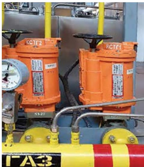
Рисунок 5.77. Стравливающие клапаны топливного газа
