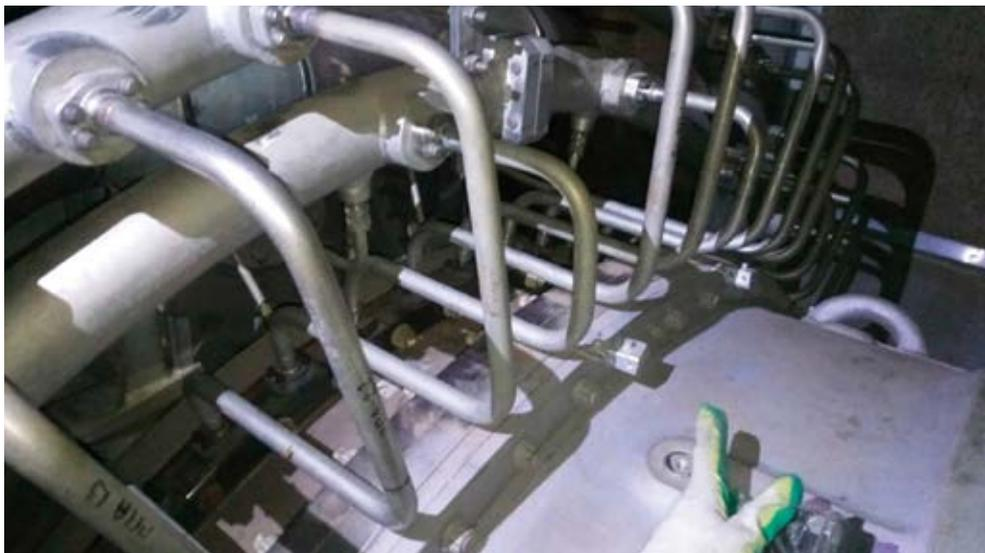
Рисунок 5.42. Трубки подачи охлаждающего воздуха от коллекторов в силовую турбину
