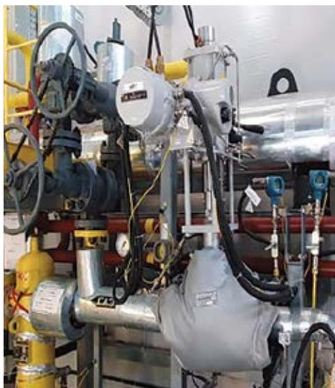
Рисунок 5.76. Регулирующий клапан топливного газа
