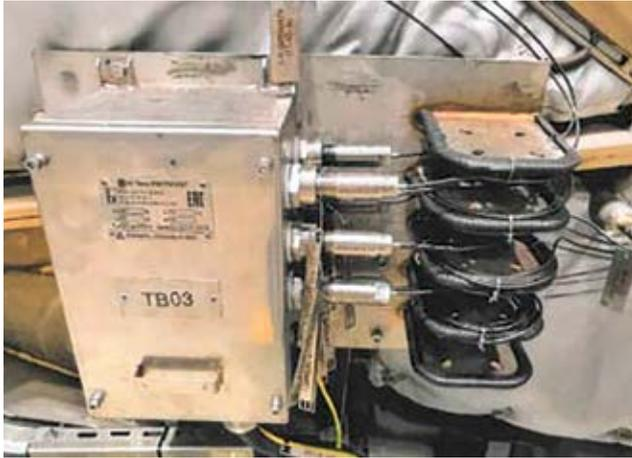
Рисунок 5.48. Улучшенный вариант крепления клеммной коробки
