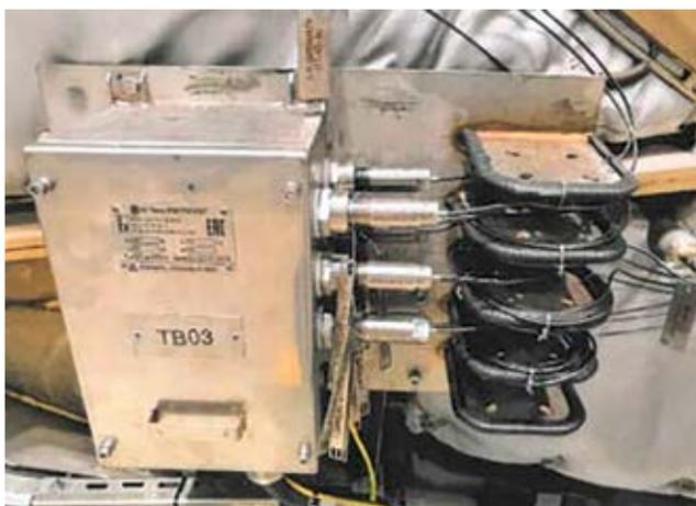
Рисунок 5.48. Улучшенный вариант крепления клеммной коробки
