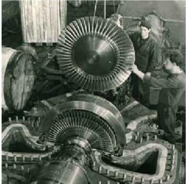
Изготовление паровой турбины
